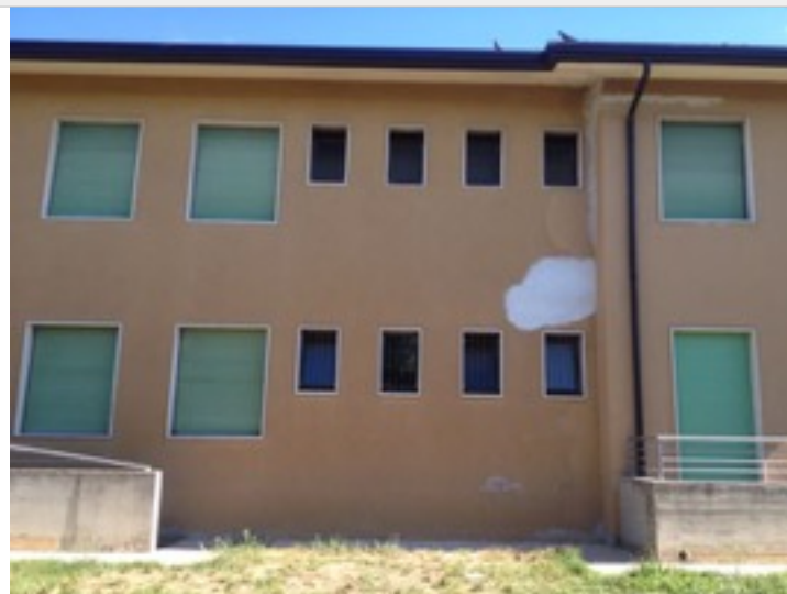
08 - prospetto sud dettaglio finestre
