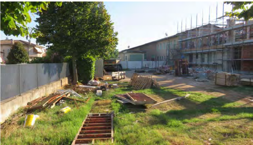
Vista 5 – cantiere in corso d’opera
