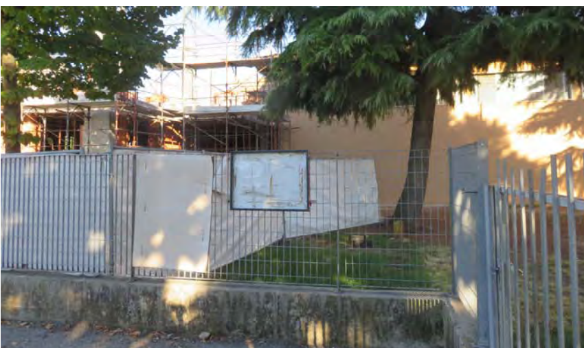
Vista 6 – cantiere in corso d’opera
