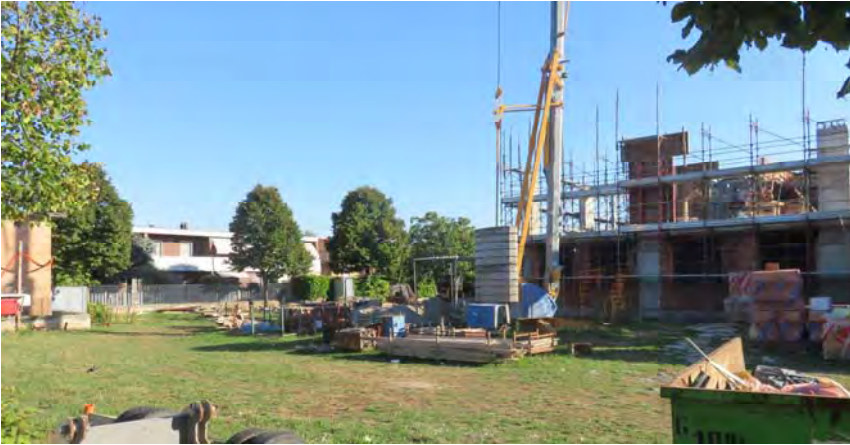
Vista 4 – cantiere in corso d’opera
