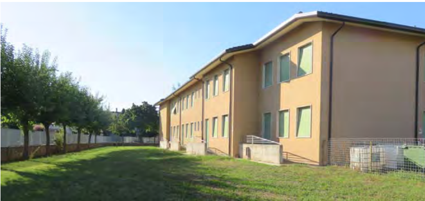
Vista 2 – cortile interno a sud
